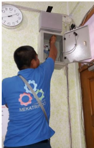
Gambar 3.5 Dokumentasi pemasangan MCB pada panel arus listrik
