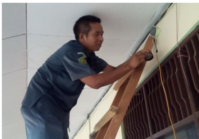
Gambar 3.6 Dokumentasi pemasangan pada bell di sekolah
