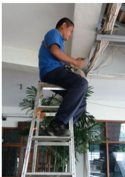
Gambar 3.7 Dokumentasi pemasangan perangkat pada lampu sekolah
